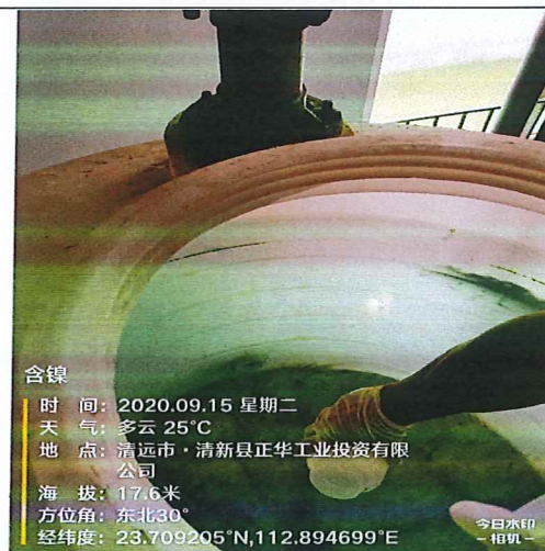
含镍车间废水排放口
